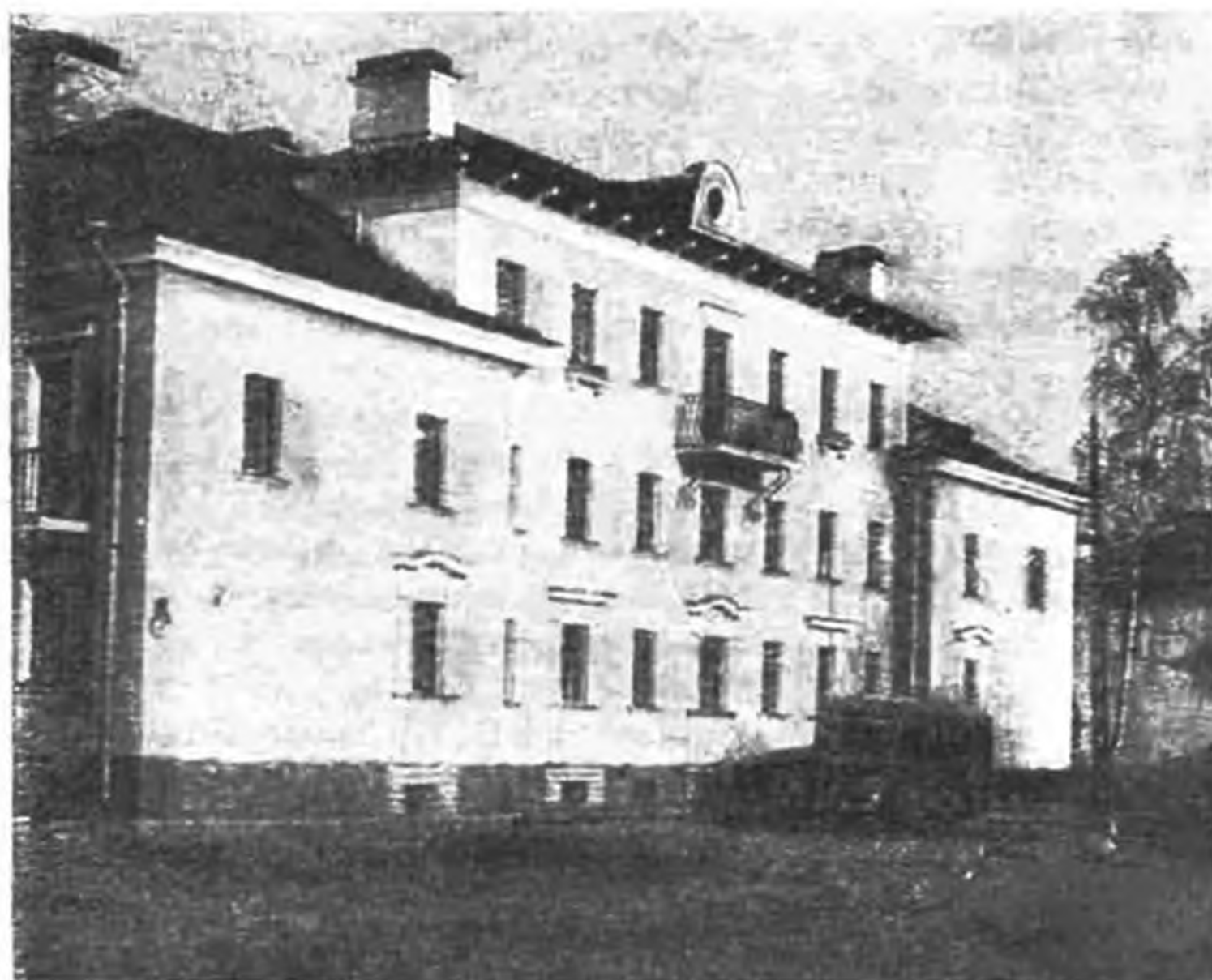
Жилой дом в Новой Деревне. Автор арх. М. Е. Русаков. Перспектива. Вверху — план 2-го этажа.
