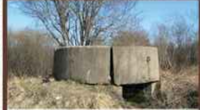
Сборная пулеметная железобетонная огневая точка.
