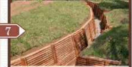
Траншея, соединяющая оборонительные сооружения.
