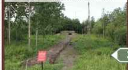
Сборная пулеметная железобетонная огневая точка.
